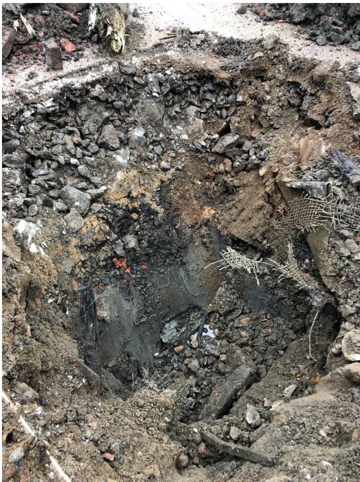
Figur 5. Jordlagerföljden i Pg 2020. Närmast markytan syns det grövre bärlagret vilket underlagras av det finkornigare fyllnadsmaterialet med inslag av tegel, trä och metall. På större djup noteras muddermassor.
